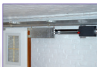
Détail du moteur
